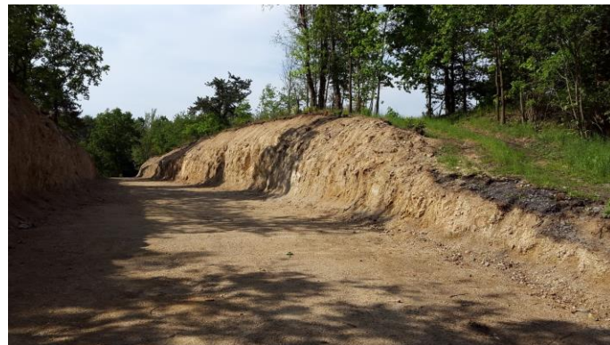
Vybudovaný bezpečnostní přeliv u hráze rybníka Horní Skviřín.
