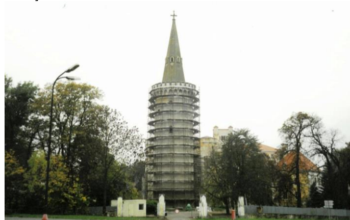
Oprava zámecké věže v roce 2002
