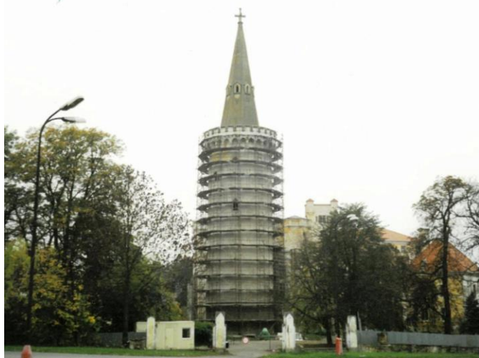
Poslední celková oprava věže v roce 2001-2002
