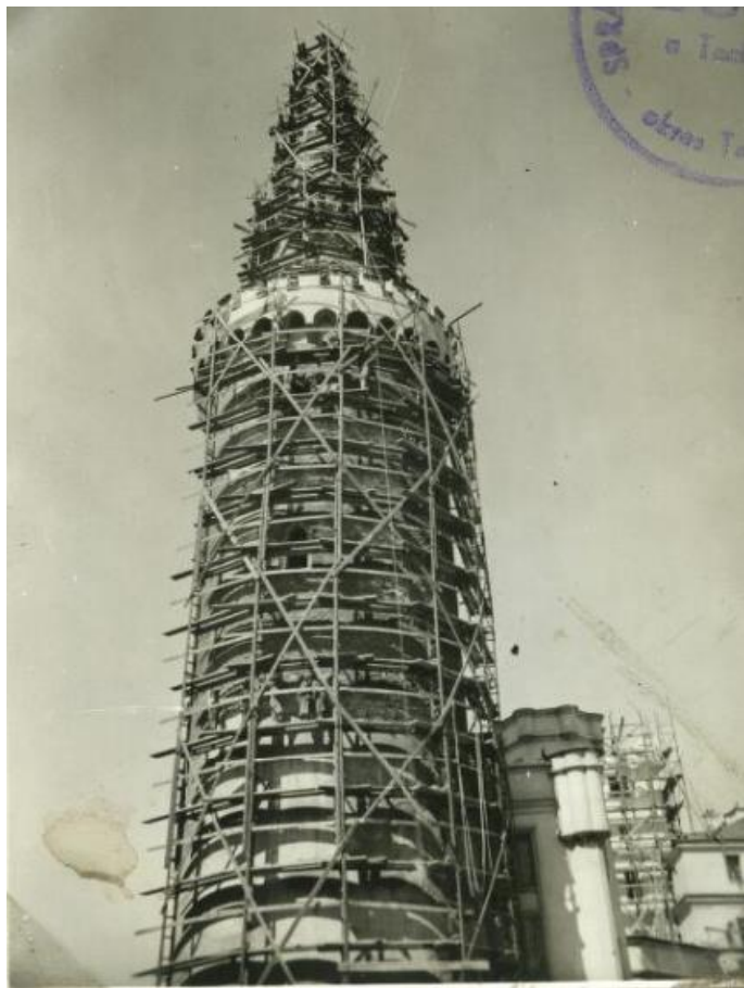
Oprava zámecké věže v roce 1930
